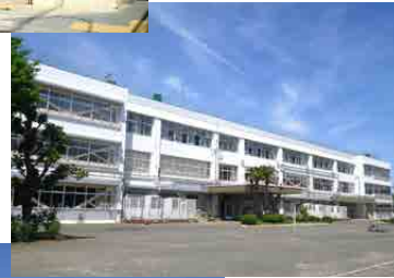
立川市立 立川第二中学校 中規模改修工事(建築)
