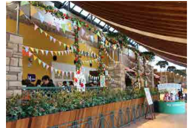
東京競馬場UMAJO スポットトイレ新設工事
