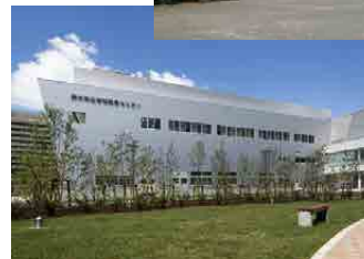
府中市学校給食センター 新築工事
